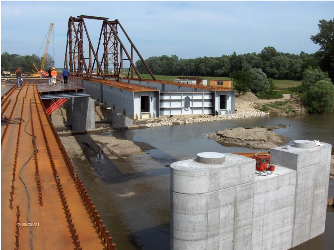
Hosszirányú betolás 2008-ban, a másik híd vasbeton pályalemezének zsaluzása
