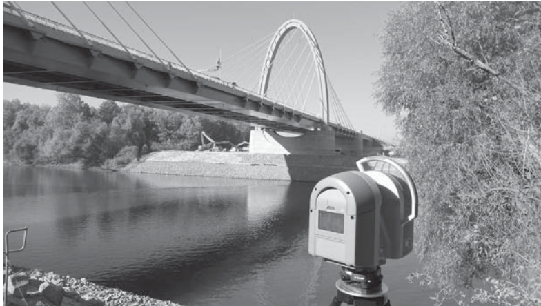
1. ábra Trimble TX8 az M44 Tisza-híd szkennelése közben
