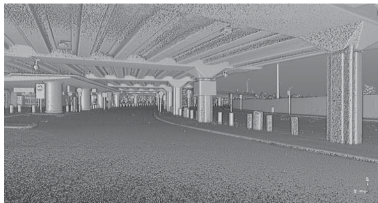
3. ábra Liszt Ferenc Repülőtér terminál körhídja pontfelhőben
