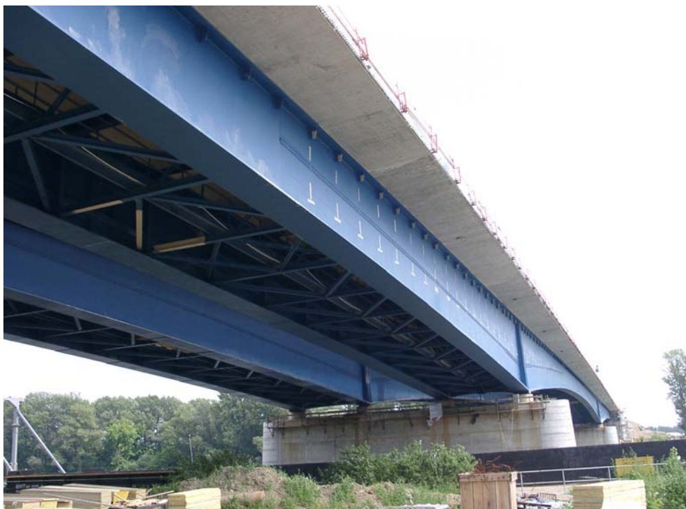
A mederhidak alulról a zsaluzattartók eltávolítása után
