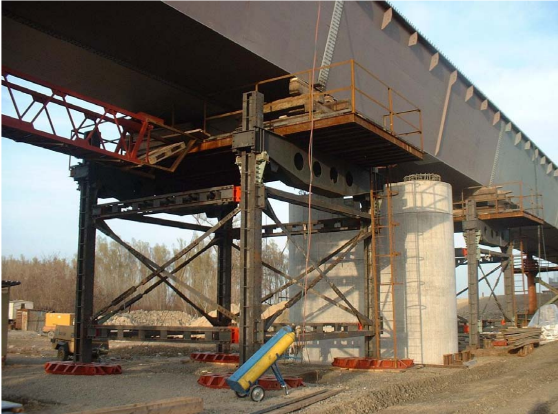
Ideiglenes alátámasztás REM 500 típusú provizórium-alátámasztásokból
