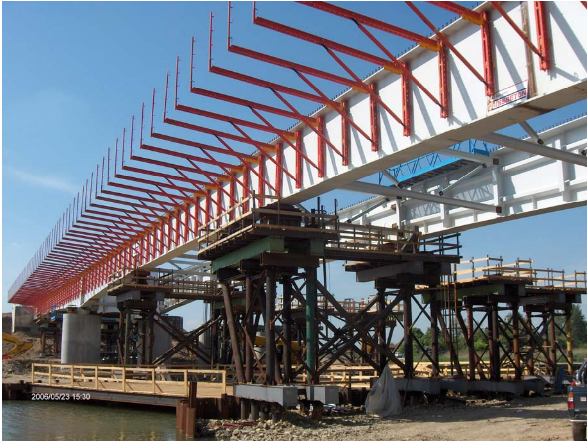
Zsaluzattartók szerelése a főtartók gerincére, előtérben a betonozáshoz is használt jármók láthatók 2006. májusán
